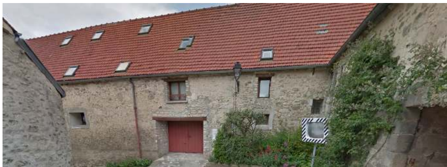
Bâtisse R+1+combles en pierre à l'alignement de la rue de la Ferme
