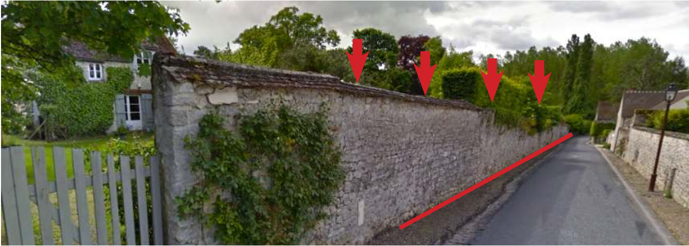
Dents creuses rue du Pont de Corne et mur remarquable en pierre à préserver.
