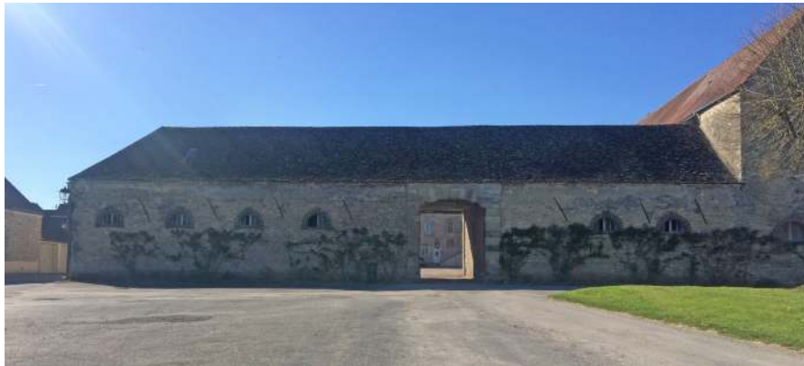
Bâtiment agricole de la ferme du Prieuré et porche en pierre marquant le fond de place du Tisart à l'ouest
