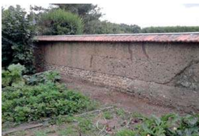
Mur de clôture en pisé
