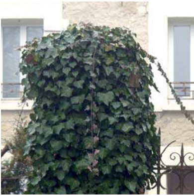
Dévégétaliser les piles et murets
