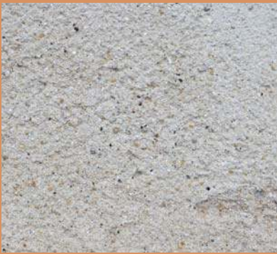
Enduit couvrant à texture grossière
