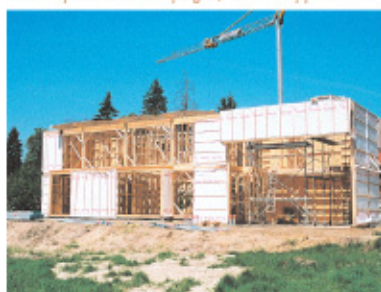
Chantier d'une maison à ossature bois
