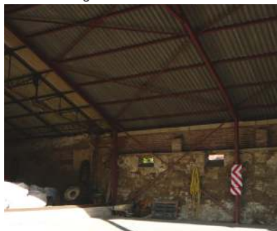
Charpente métallique disposée à l'intérieur d'un ancien bâtiment agricole.
