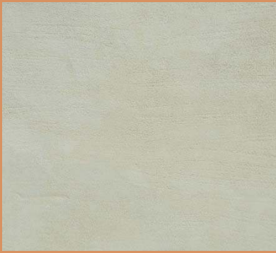
Enduit couvrant étiré à la taloche
