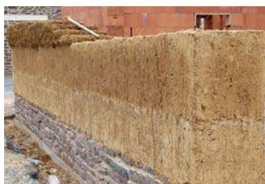
Mur en bauge en cours de construction
