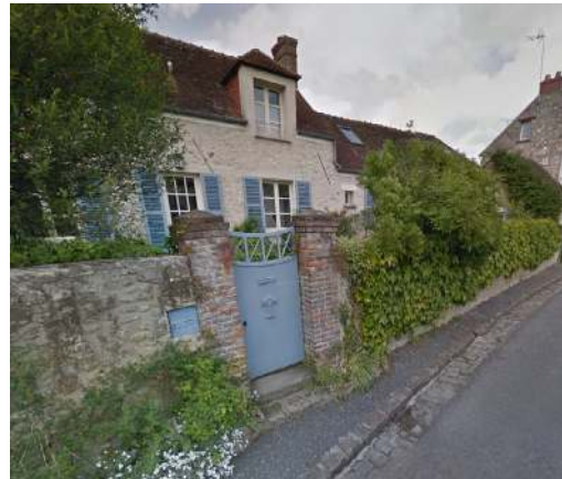
Maison en retrait de rue et mur à l'alignement
