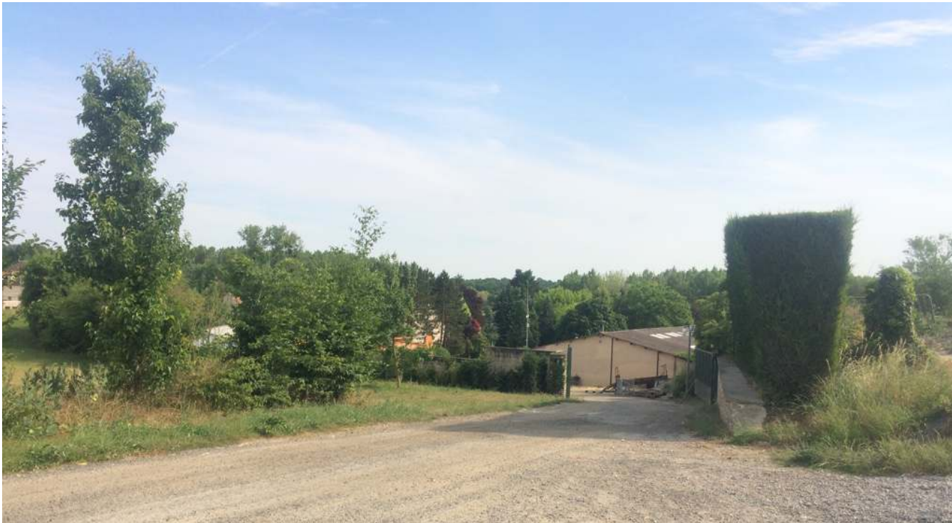
Vue sur l'entreprise de travaux publics en frange ouest du bourg depuis la rue Sole des Ponts.
