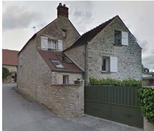
Différents niveaux et pentes de toiture sur le bâti ancien
