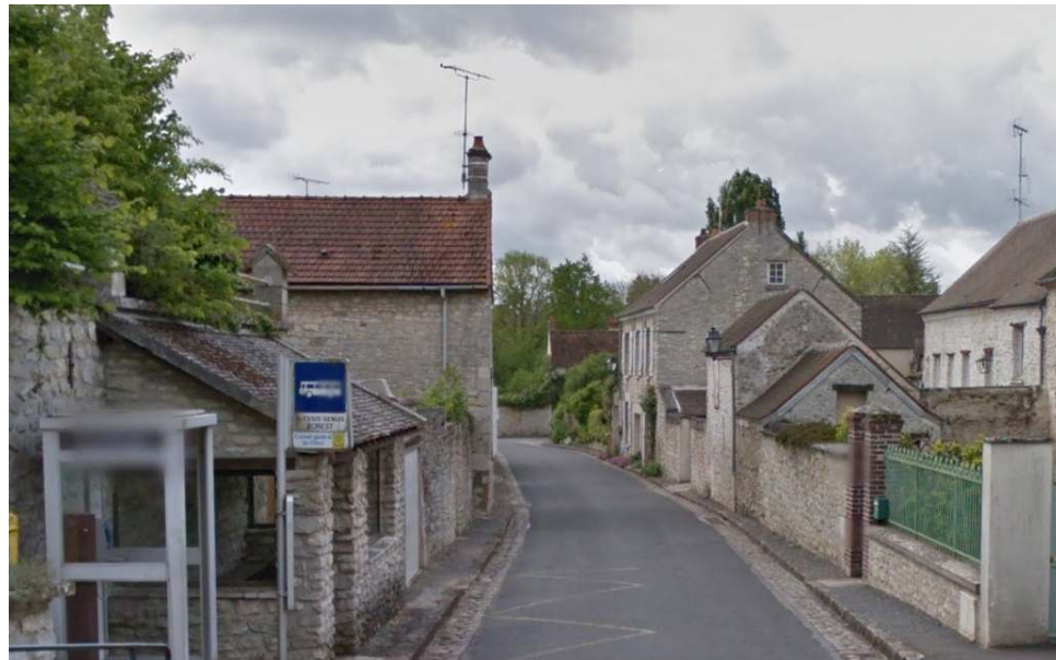
Arrêt de bus en pierres de pays rue aux Pierres
