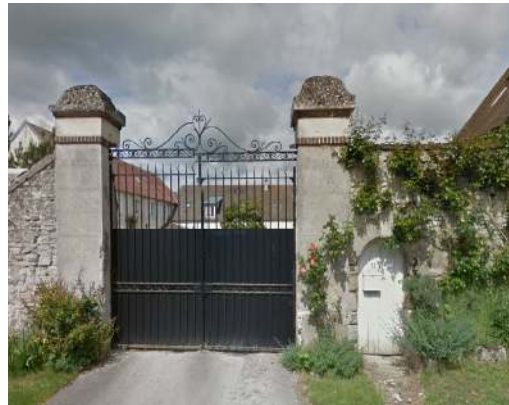
Ancien corps de ferme en U rue du Pont de Corne
