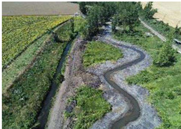
Travaux de restauration de la Nonette et de sa zone humide menés par le SISN en 2023 à Baron
