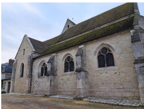
Piquage des joints entre les pierres et nettoyage/jointement des pierres des trois arches de la façade nord
