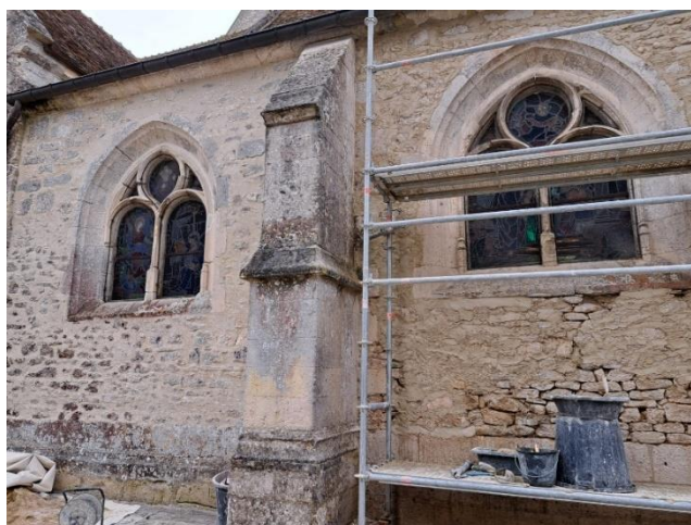
Piquage des joints entre les pierres et nettoyage/jointement des pierres des trois arches de la façade nord
